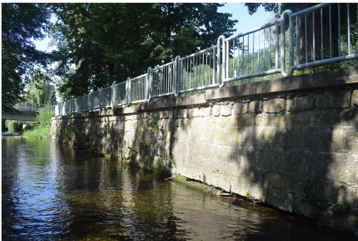
ř. km 20,327 – 20,357 oprava založení a přespárování PB zdi (pohled po vodě)
