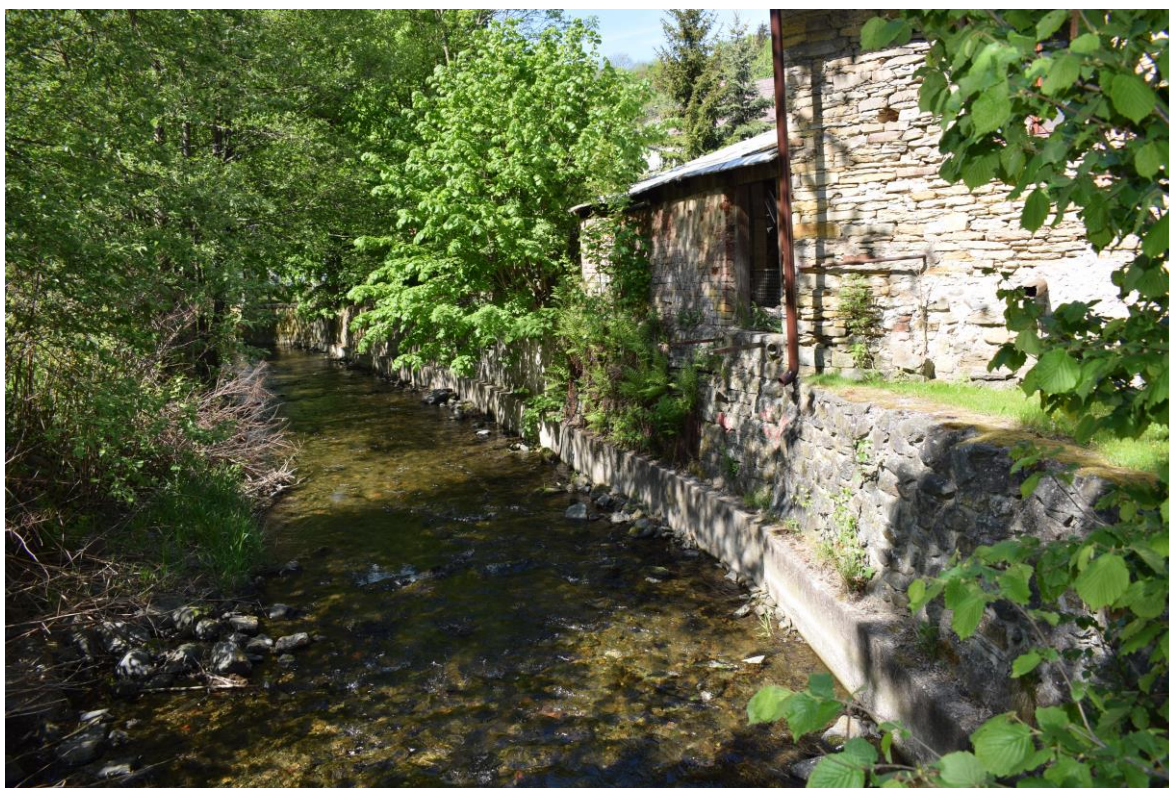
ř. km 20,417 – 20,426 přespárování PB zdi (pohled po vodě)
