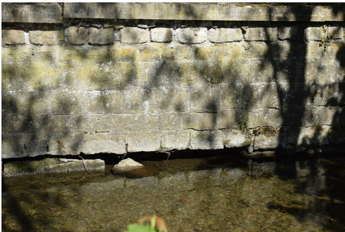
ř. km 20,327 – 20,357 detail poškozeného založení PB zdi (pohled z levého břehu)
